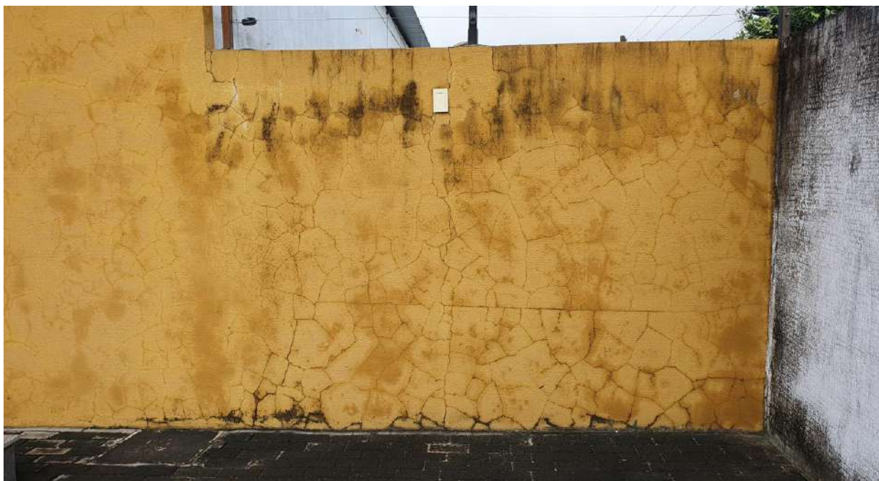
Fotografia 11 – Paredes da fachada danificadas – Fonte TRE/PI.
