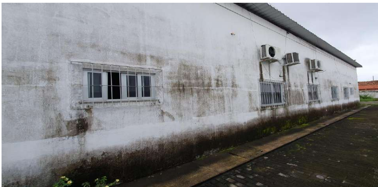
Fotografia 16 – Rodapé com umidade / área externa – Fonte TRE/PI.
