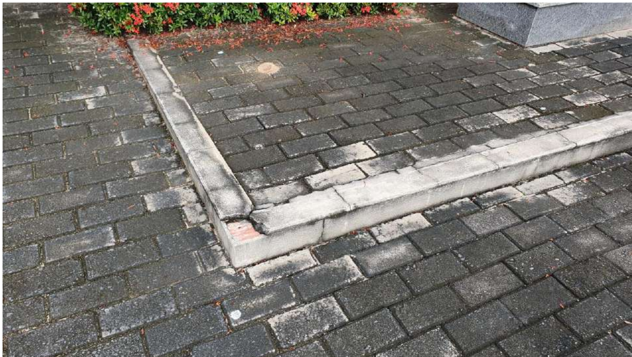
Fotografia 14 – Guia meio-fio a ser revitalizado – Fonte TRE/PI.
